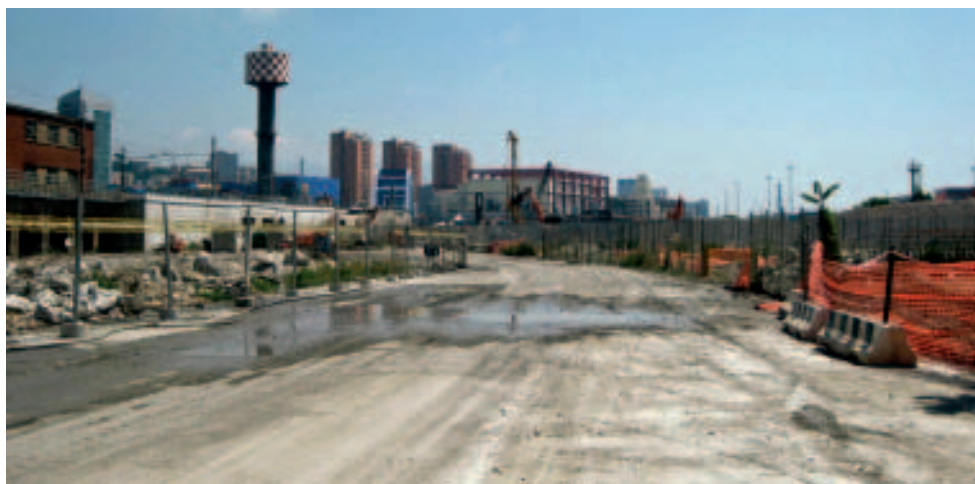
Il cantiere. L'area dove sorgerà la strada a mare
